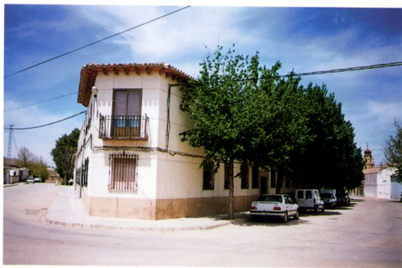
CALLE DE LA GINETA.
