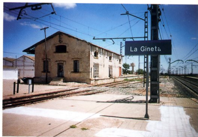
VISTA ACTUAL DE LA NAVE DE RENFE.
