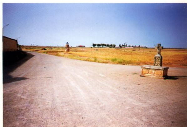
CAMINO DEL CEMENTERIO MUNICIPAL.
