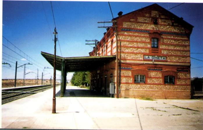
ESTACION DE RENFE.
