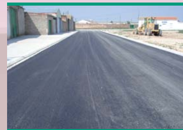
Obra P.O.S. 2008 asfaltado Calle Ganaderos a Tanatorio
