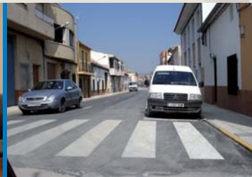
Asfaltado de 2 tramos de la calle Camino Real
