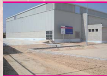
Pavimentación entorno Pabellón Polideportivo
