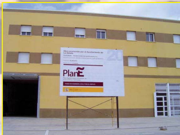
Edificio Municipal en Polígono Torovizco
