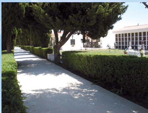
Construcción de nichos
