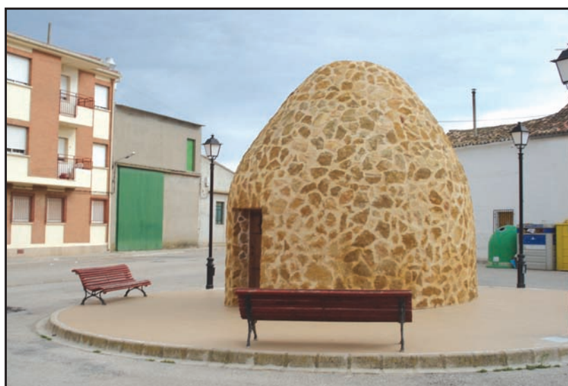
Rehabilitación Cuco y plaza.
